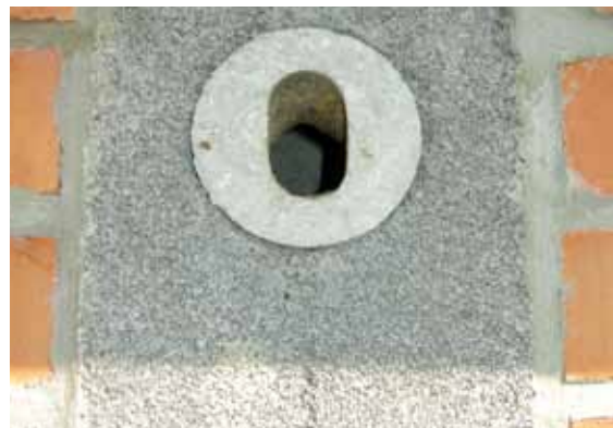
Speciální budka zapuštěná do fasády domu s otvorem částečně zazděným brhlíkem lesním. Tyto odolné budky jsou vyráběny z dřevěných pilin, cementu a dalších příměsí. Foto: Josef Chytil
